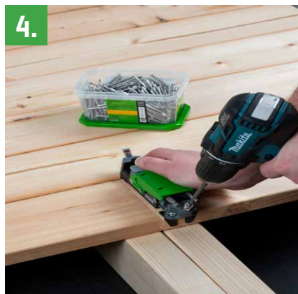
4. Kasuta paigaldamisel HDS-otsakut; alusta alati välimisest kruvist.
